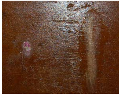
Chemical Indicator Test (Wall)
